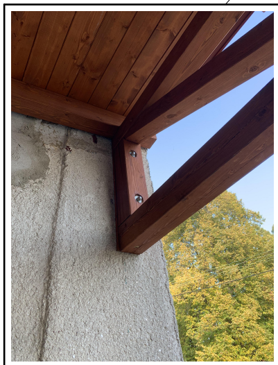
DŘEVĚNÝ NOSNÍK KOTVEN DO STÁVAJÍCÍHO ZDIVA
